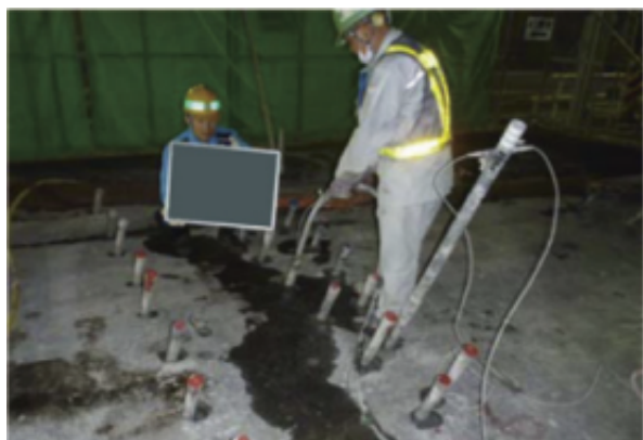
削孔・一次注入
